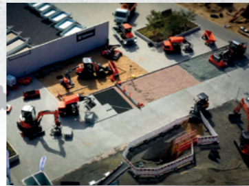
Musterbaustelle im Coreum, Stockstadt a. R.
